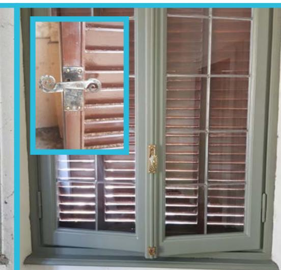
**Il restauro delle finestre prevede interventi conservativi sui telai, sulle superfici, sui vetri e loro sistemi di fissaggio e ferramenta, ed eventuali integrazioni di parti mancanti o ammalorate, non una modifica del serramento.**
