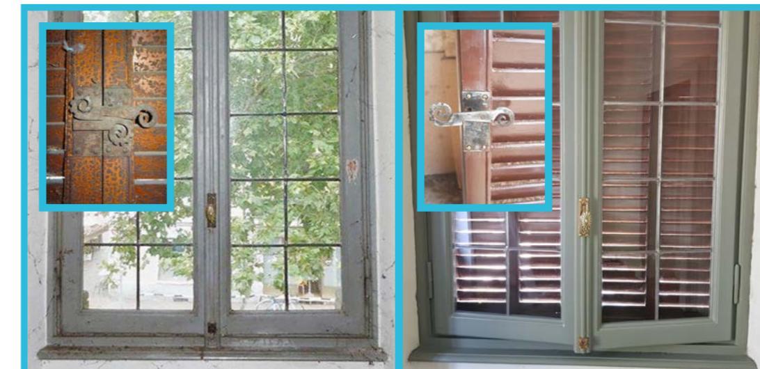
**Bei der Restaurierung von Fenstern handelt es sich um konservierende Arbeiten an Rahmen, Oberflächen, Glas und deren Befestigungssystemen und Beschlägen sowie um die Ergänzung fehlender oder beschädigter Teile, nicht um eine Veränderung des Fensters.**
