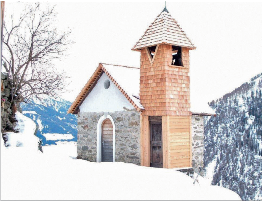
Die Kapelle beim Waldhof nach der Sanierung
