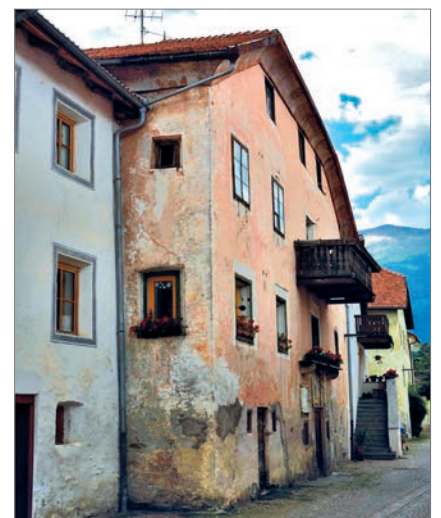
Sechs Wohnungen entstehen in diesem Gebäude. (Foto: LPA)
