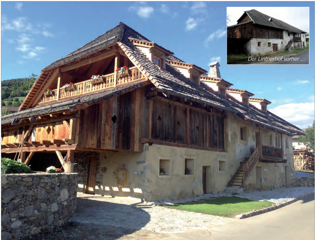
Vorderansicht nach der Renovierung: Mit Ausnahme der Giebfenster wurde die Außenfassade in ihrer Gesamtheit erhalten.
