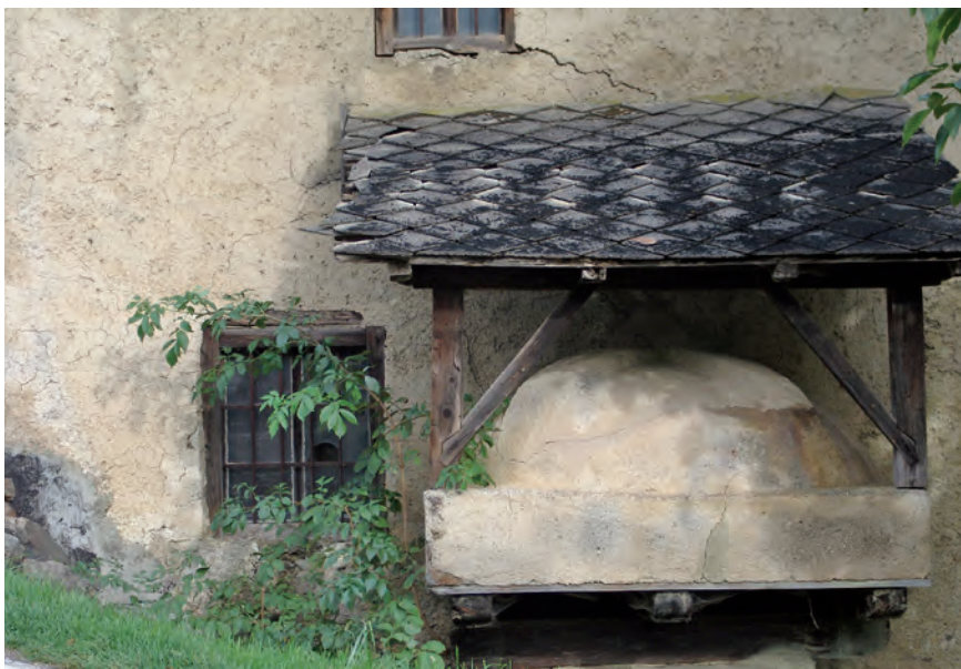
Warten auf den Abbruch (Foto Hempel)
