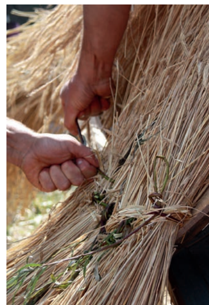
Paul Lun vom Dureggghof befestigt mit zugespitzten Weidenruten die Schaben an den Dachlatten (Modell)
