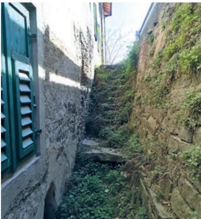
Das Gebäude „zur Lende“ steht heute zum Teil „unter der Erdoberfläche“ (Bild links), weil der Etschdamm durch die Regulierung immer höher wurde. Zu erkennen ist das auch an den in verschiedenen Phasen gebauten Mauern (zu sehen auf den Bildern in der Mitte und rechts).
