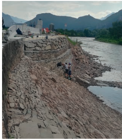
Die Sanierung des Etschdammes dauerte mehrere Monate, wobei die Rampen aus den verschiedenen Epochen harmonisch miteinander verbunden wurden (Bild Mitte). Bei den Arbeiten wurde auch eine alte Flusstreppe (Bild rechts) entdeckt und saniert.
