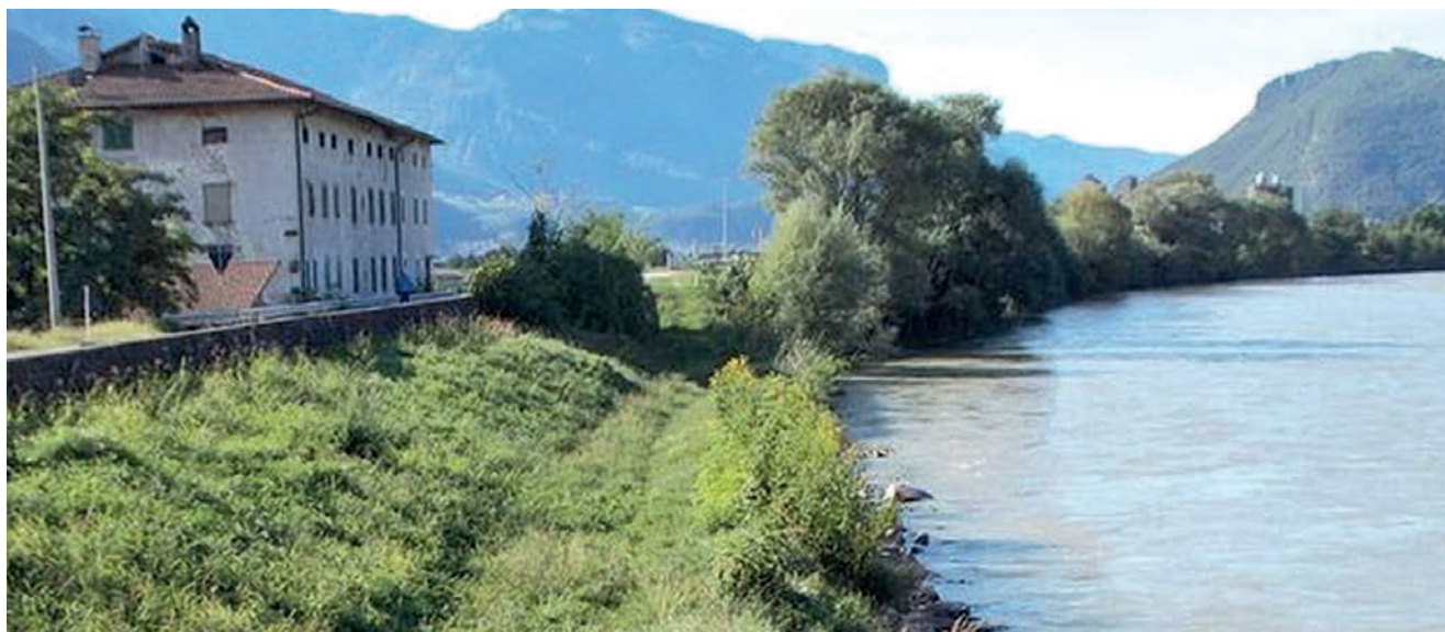
Das Etschufer vor den Sanierungsarbeiten. Beinahe wären die historischen Rampen dem Erdboden gleichgemacht worden.
