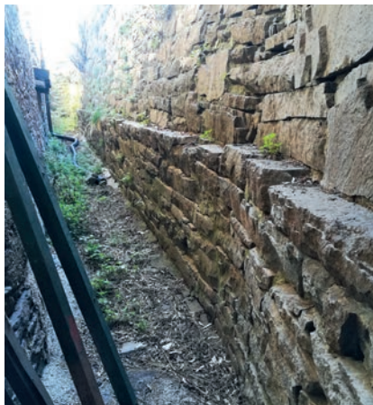
Das Gebäude „zur Lende“ steht heute zum Teil „unter der Erdoberfläche“ (Bild links), weil der Etschdamm durch die Regulierung immer höher wurde. Zu erkennen ist das auch an den in verschiedenen Phasen gebauten Mauern (zu sehen auf den Bildern in der Mitte und rechts).
