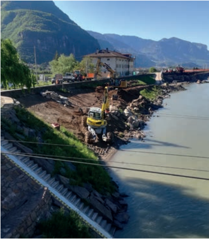
Die Sanierung des Etschdammes dauerte mehrere Monate, wobei die Rampen aus den verschiedenen Epochen harmonisch miteinander verbunden wurden (Bild Mitte). Bei den Arbeiten wurde auch eine alte Flusstreppe (Bild rechts) entdeckt und saniert.
