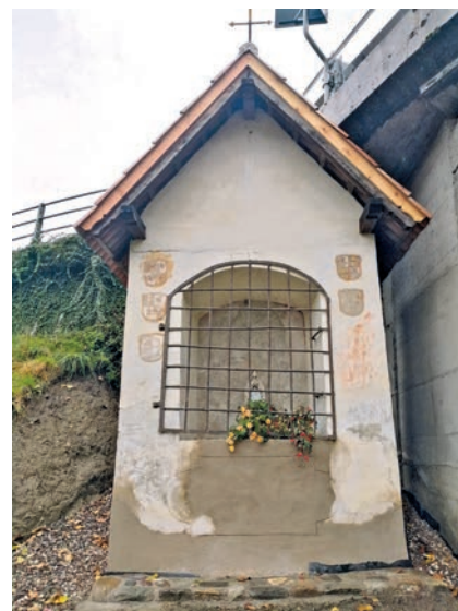
Der Braunsberg-Bildstock wurde einer umfangreichen Drainage unterzogen und neu verputzt.
