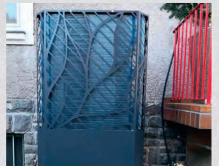
**Eine Luft-Wärmepumpe saugt Luft von außen auf und wandelt sie mit Hilfe von Strom in Wärme um. Der Stromverbrauch hängt vom Temperaturunterschied ab, ist aber vergleichsweise gering.** Fotos: Privat
