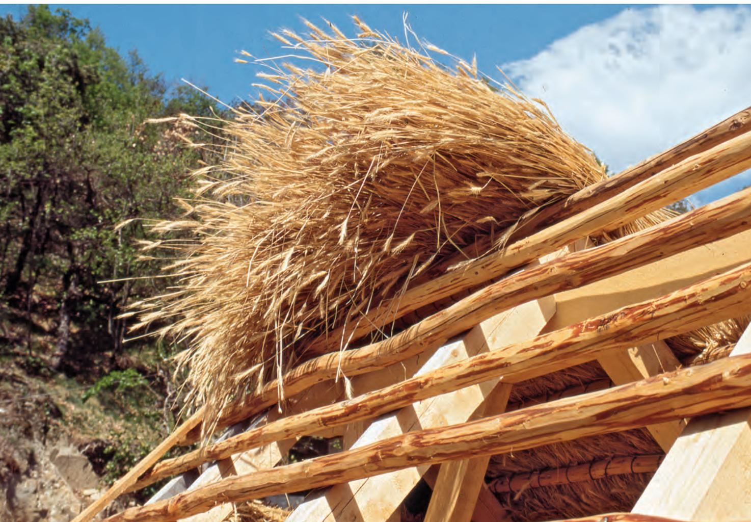
**Durchschnittlich 30 Jahre hält ein Strohdach. Nahezu jedes Jahr ist ein Streifen des Daches neu einzudecken.**
