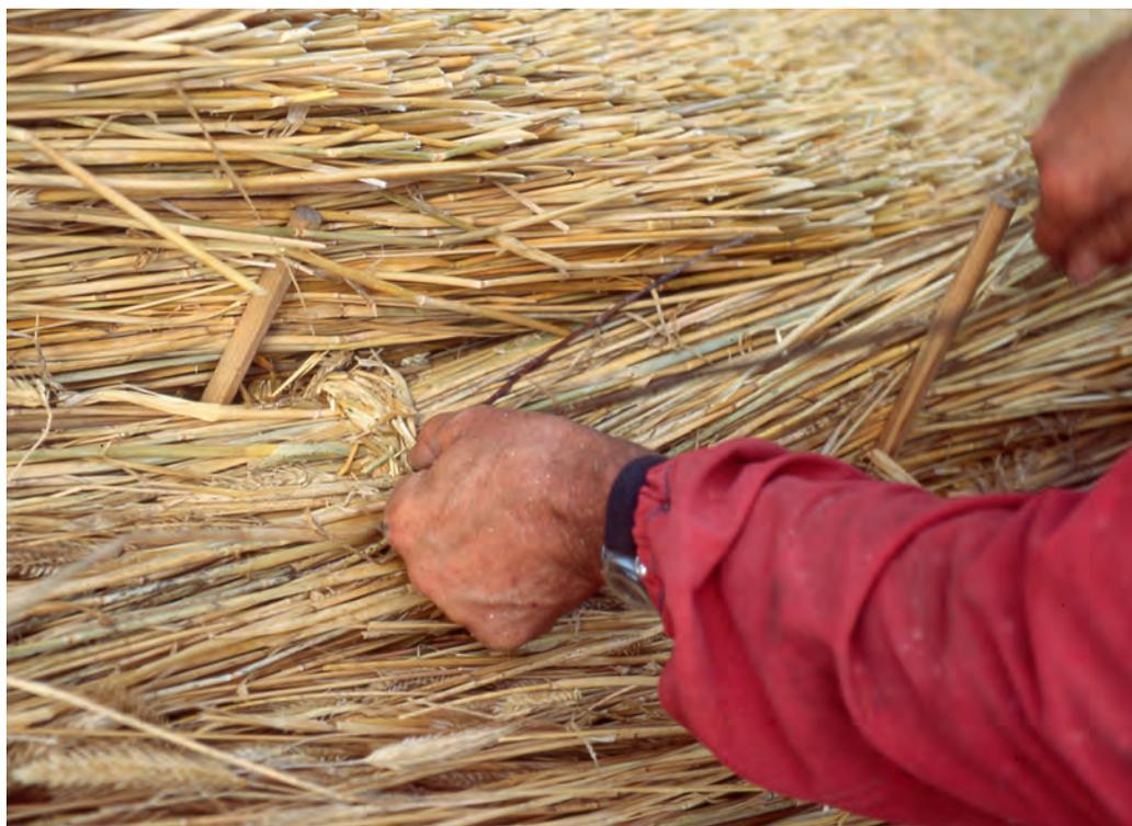
**Nur Herbstroggen eignet sich zum Dachdecken. Er muss gut gereift und getrocknet sein, wird zu Schab (Strohbündeln) gebunden und in Streifen aufs Dach gelegt.** Foto: HPV
