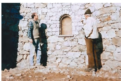
Hans und sein Neffe Karl Hofer beim Errichten einer Trockenmauer.
