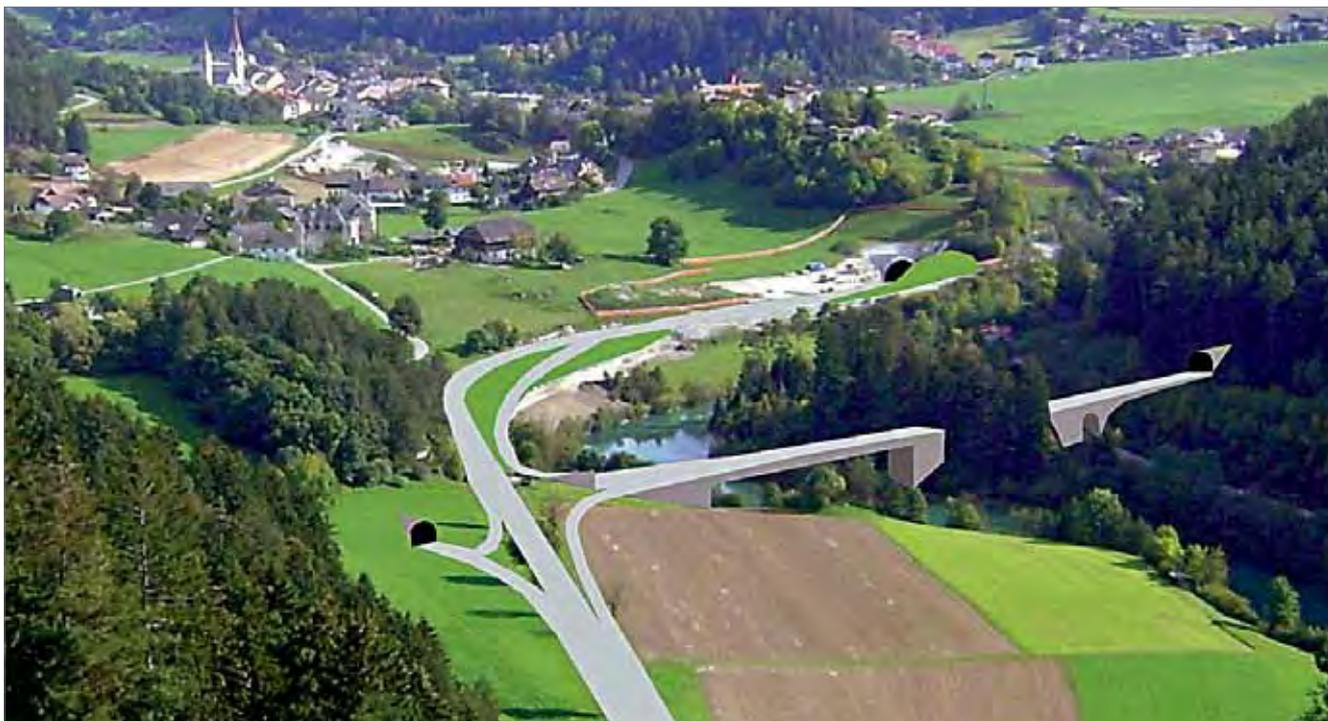
*Sonnenburg/Klosterwald: Ein Straßenbauprojekt von 40 Mio. Euro mit einem Tunnel unter der Sonnenburg, einer 90 m langen ansteigenden Brücke über Rienz und Eisenbahn, einem 850 m langen Tunnel bei Klosterwald und die aufwändigen Kreuzungsbauwerke werden die Probleme mit den Verkehrsspitzen auf der Gadertaler Straße und im Bereich St. Lorenzen auch in Zukunft nicht lösen. Das Ensemble Sonnenburg – ein einmaliges Kultur- und Naturjuwel im Pustertal – wird damit aber definitiv zerstört!*
