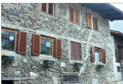
Eine gelungene Sanierung
