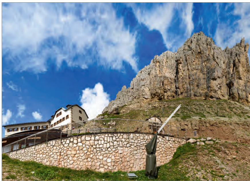
Die Kölner Hütte im derzeitigen Zustand unterm Rosengarten (Foto: AdobeStock)
