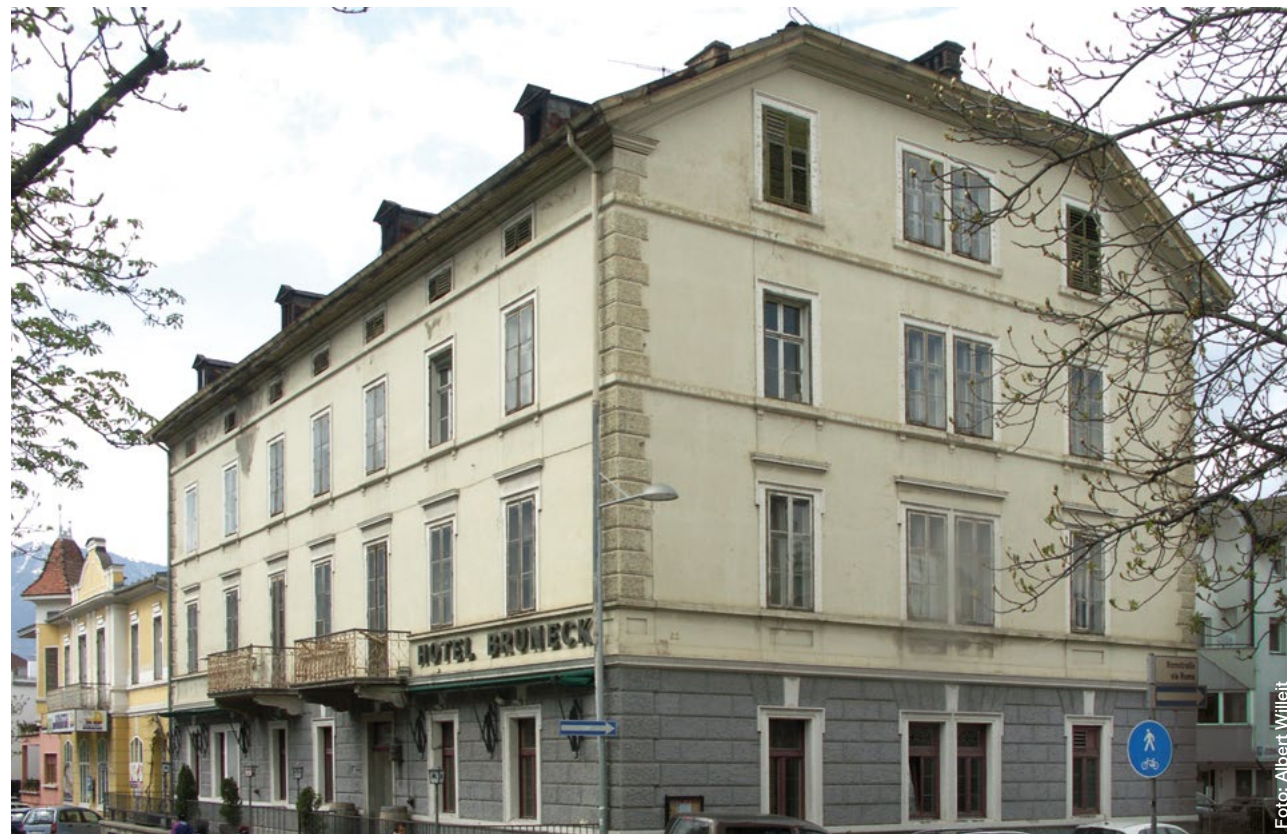
Abb. 10: Urteil Hotel Bruneck: Für die vorübergehende Unterschutzstellung einer Liegenschaft aus Gründen der besonderen Dringlichkeit ist die Mitteilung der Eröffnung des Verfahrens nicht notwendig. Die vorläufige Unterschutzstellung muss nicht das gesamte Ensemble betreffen, sondern kann auf das mindest notwendige Maß eingeschränkt werden.
