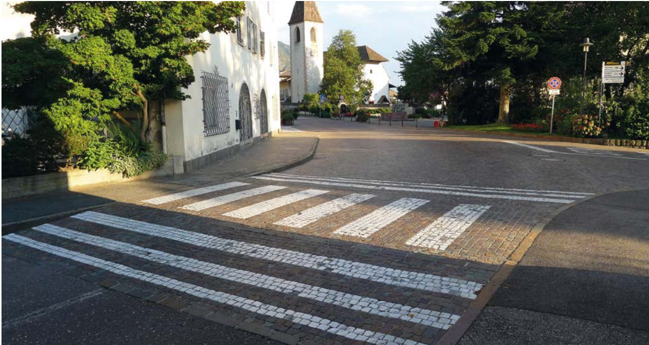
Abb. 5: Gargazon - Dorfstraße mit sicherem Fußgängerübergang durch Aufpflasterung
