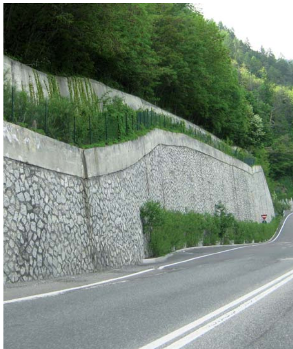
Umfahrung Mühlbach 15 Jahre nach Fertigstellung Versuch einer Begrünung
