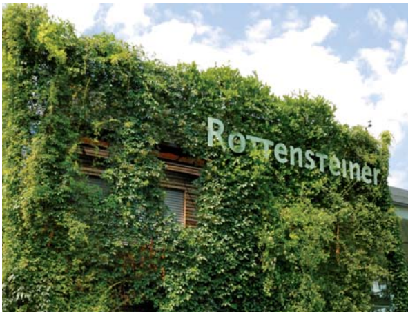
Fassadenbegrünung Gärtnerei Rottensteiner in Bozen
