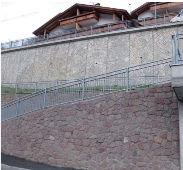
Riesige steinkaschierte Stützmauern in Kollmann
