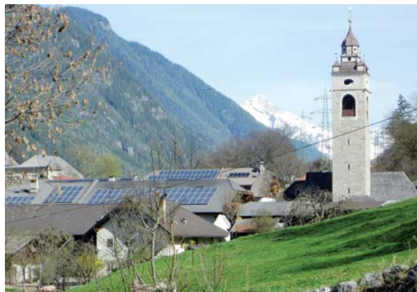
Photovoltaikanlagen in Aufhofen
