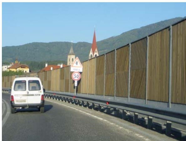
Umfahrung St. Lorenzen ortsbildverstellende Schallschutzmauer
