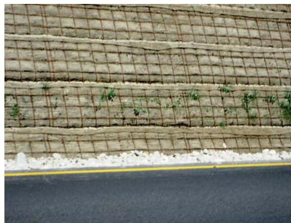
Umfahrung Vintl Schallschutzmauer mit bewehrter Erde im Rohbau
