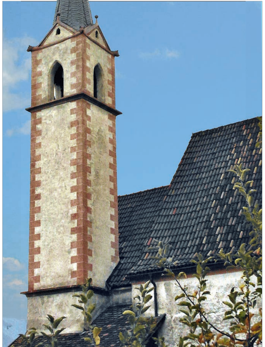
Der restaurierte Kirchturm der St.-Agatha-Kirche
