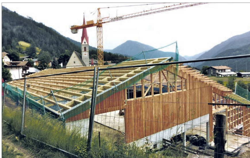
Die neue riesige Reithalle verdeckt den Blick auf die Wallfahrtskirche Maria Trens
